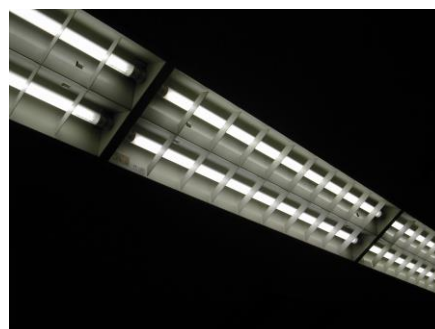
事務所と倉庫の一部の蛍光灯をLEDに更新 (とても明るいです)
