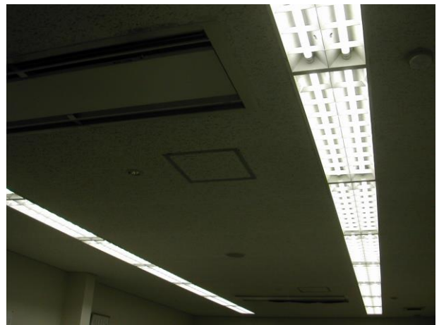
事務所の蛍光灯をLEDに更新
